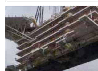
公司为荷兰SBM公司建造的Fast4Ward®“通用型”海上浮式生产储油船(FPSO)H1498船生活楼上建吊装上船。
